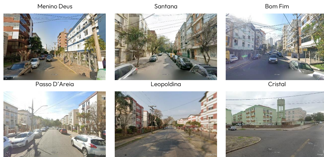
Figura 31 – Exemplo de ocupação consolidada por edifícios de baixa altura. 180
